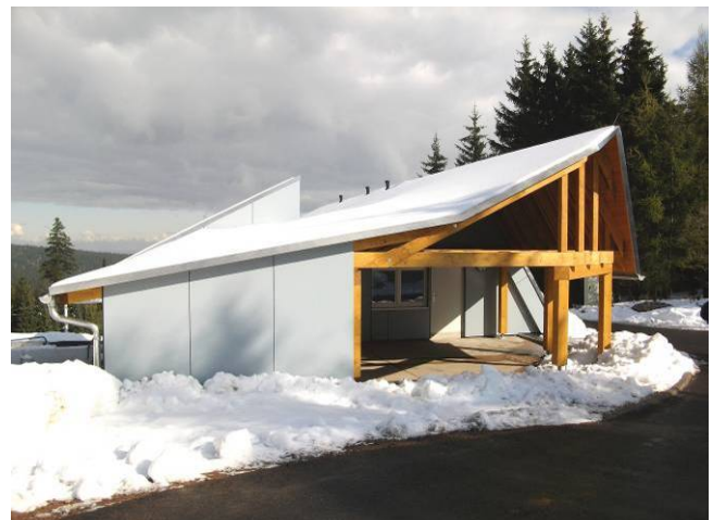
Erweiterung der überdachten Aufstellfläche für Sportgeräte, Sanierung Umkleieräume für Sportler
