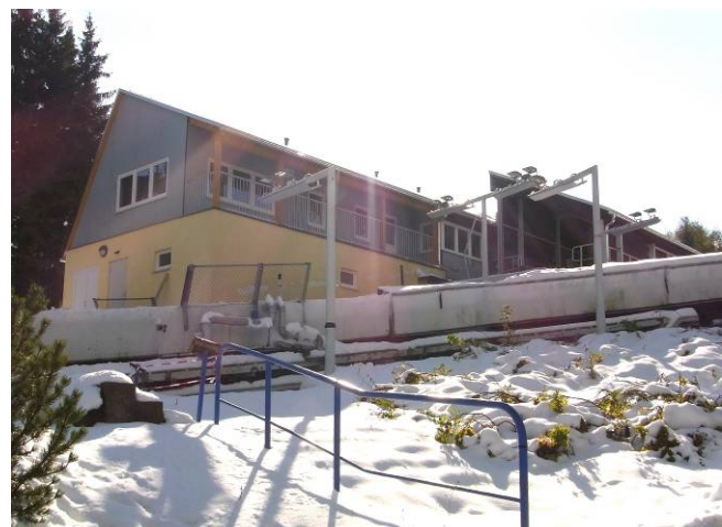
neu angebauter Gebäudeteil mit Aufenthaltsraum und Terrasse
