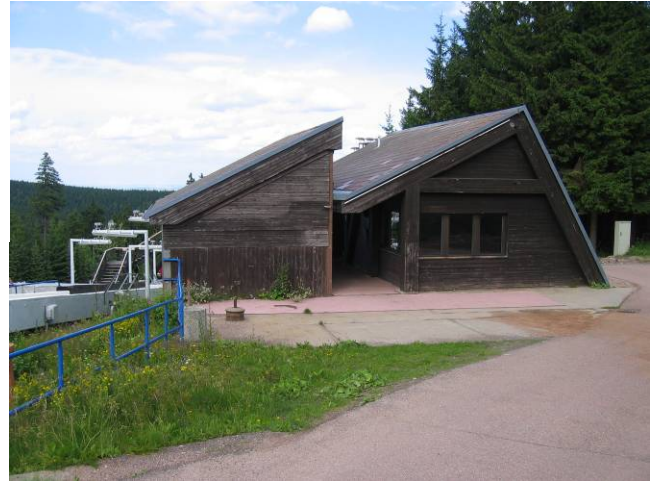
Gebäudeansicht vor dem Umbau
