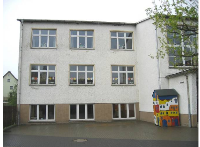
Fassade vor der Sanierung
