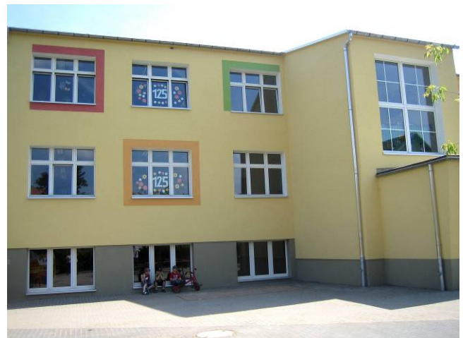
Fassade mit Wärmedämmung und neuer Farbgestaltung
