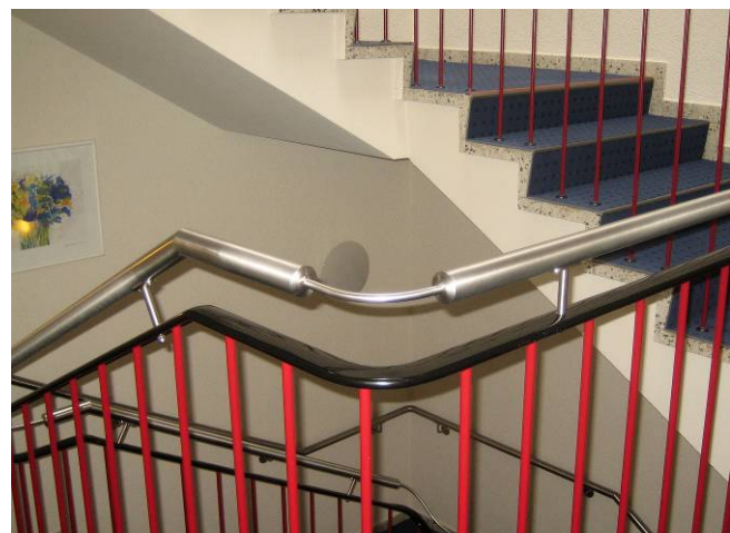
Modernisierung Treppenhaus (Geländer, Bodenbelag, Wandfarbe)
