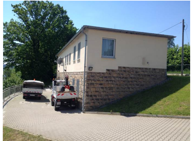
Dienstgebäude vor Umbau
