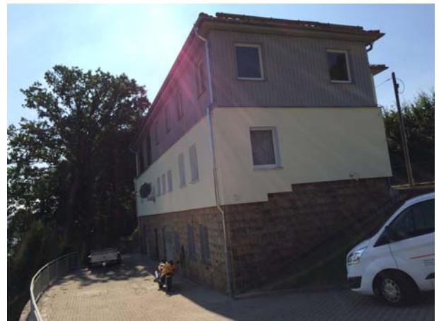
Dienstgebäude nach Umbau, Ansicht Nord-Ostseite
