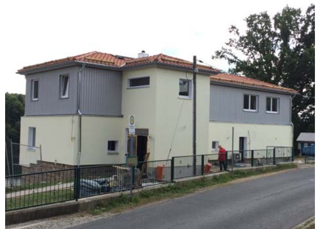
Dienstgebäude nach Umbau, Ansicht Nord-Westseite
