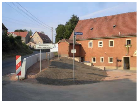
Schlossgasse 1 nach Abbruch
