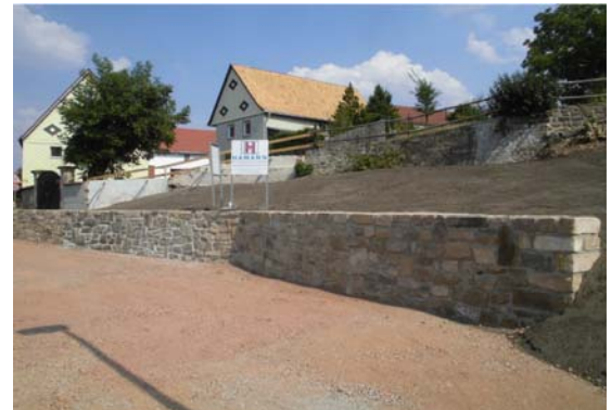
Grimmsche Hauptstraße 33 nach Abbruch
