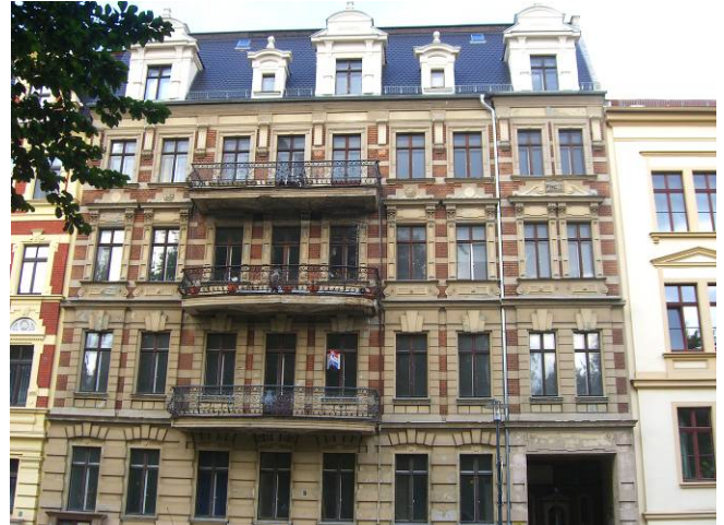
Straßenfassade vor der Sanierung
