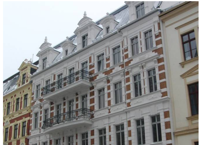
Straßenfassade nach der Sanierung
