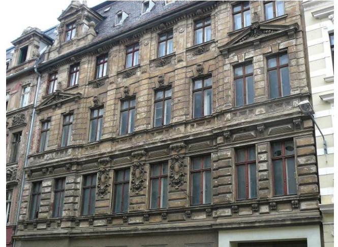
Fassadenansicht vor der Sanierung
