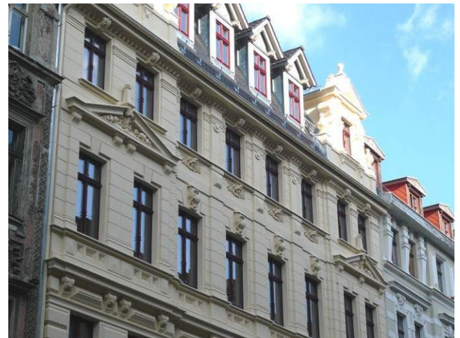
Fassadenansicht nach der Sanierung
