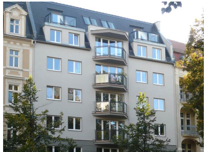
Strassenansicht nach der Sanierung
