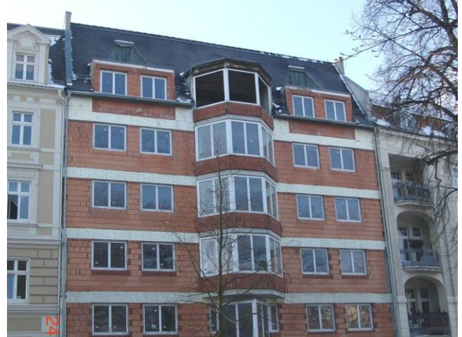
Strassenansicht vor der Sanierung
