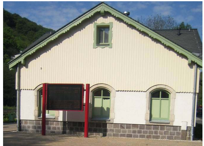
saniertes historisches Servicegebäude
