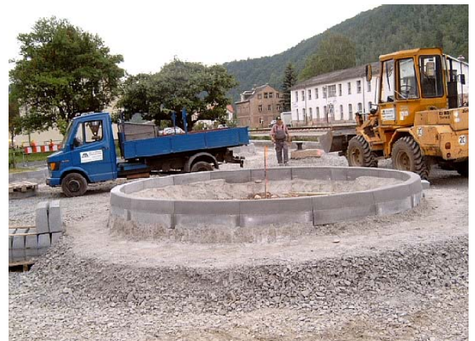
Wendeanlage während der Bauphase
