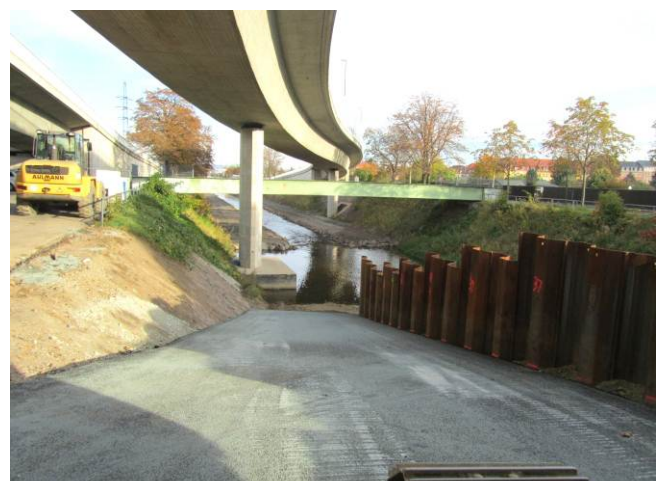
Gewässerzufahrt 7 stromabwärts unter der Löbtauer Brücke
