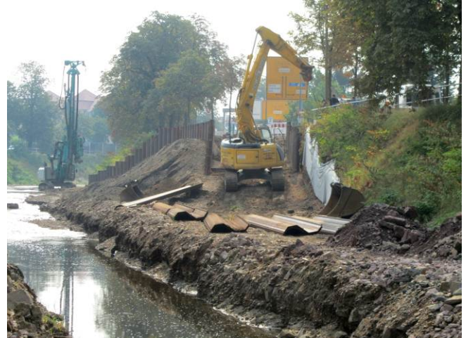
Gewässerzufahrt 8.1 stromaufwärts vor der Brücke Fröbelstraße
