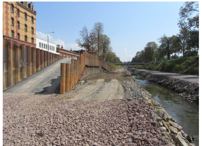
Gewässerzufahrt 5.2 stromaufwärts vor der RWA- Brücke
