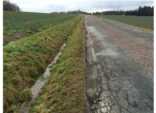
Straßenabschnitt vor Sanierung
