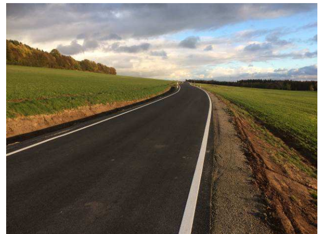
Straßenabschnitt nach Sanierung
