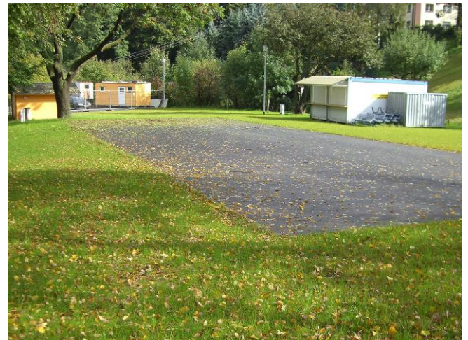
Dorfplatz nach Fertigstellung mit befestigter Fläche für Festzelt
