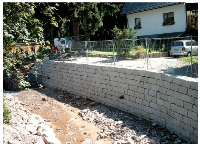
Schwergewichtswand nach Fertigstellung
