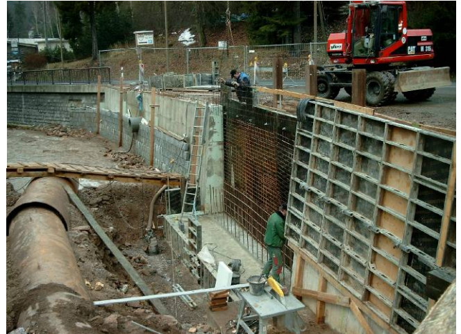
Winkelstützwand während der Bauphase
