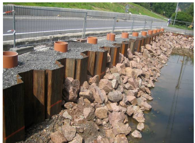
Stützwand 3 während der Bauphase
