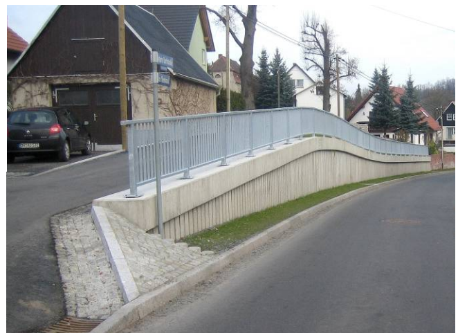
Stützwand 4 nach der Baumaßnahme
