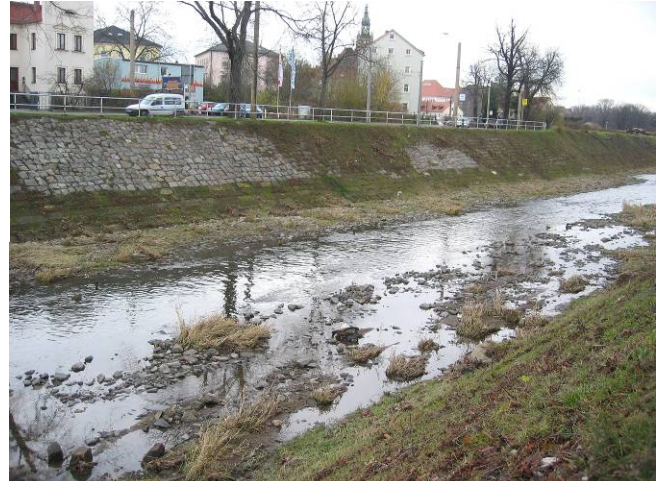
Uferbereich vor Baubeginn
