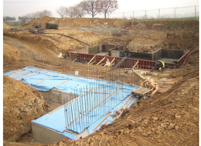
Anlegen der Fundamente
