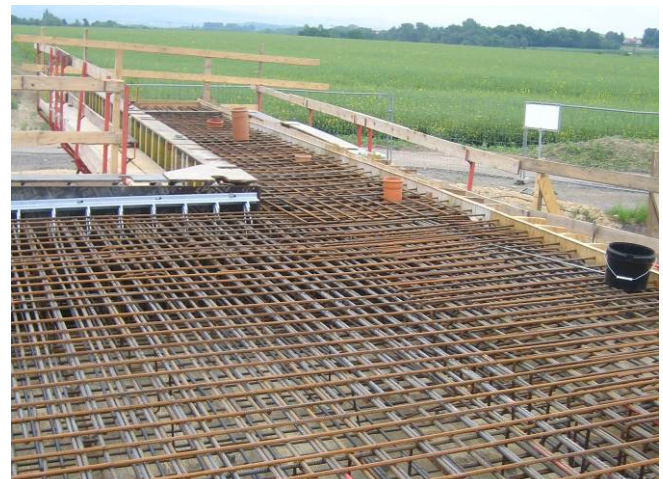
Bewehrung Brückenplatte und Flügelwand
