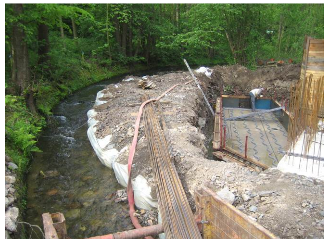
Anlegen der Fundamente
