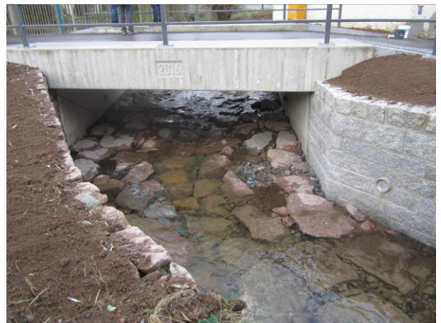
neues Brückenbauwerk mit Sohl-sicherung und Flügelmauer
