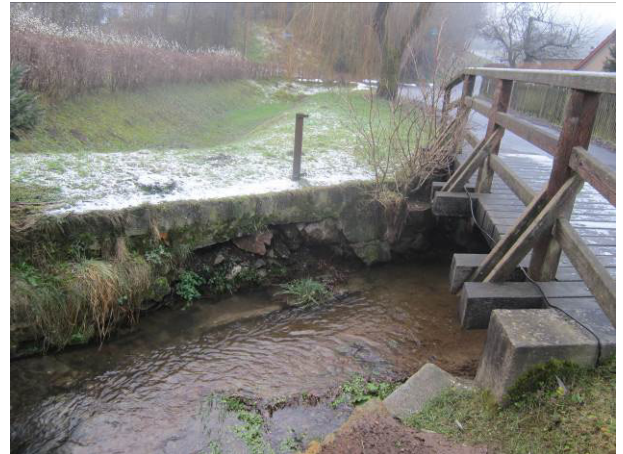
Brücke im Bestand Reinhardtsgrimmaer Straße
