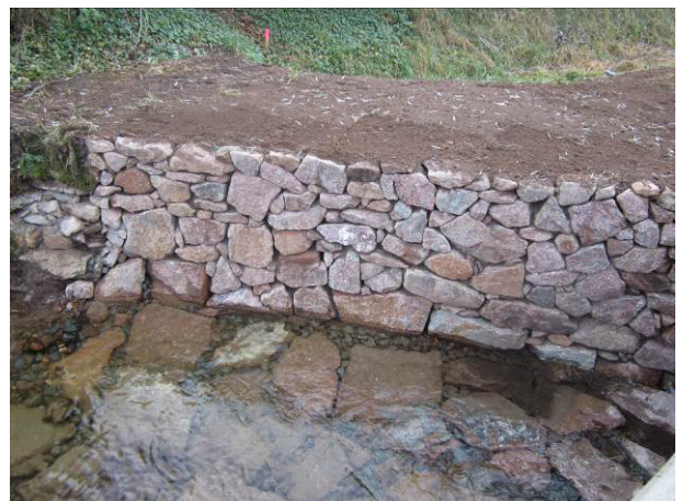
Steinsatz als Böschungssicherung
