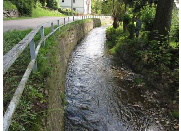
Ufermauer im Bestand vor Neubau
