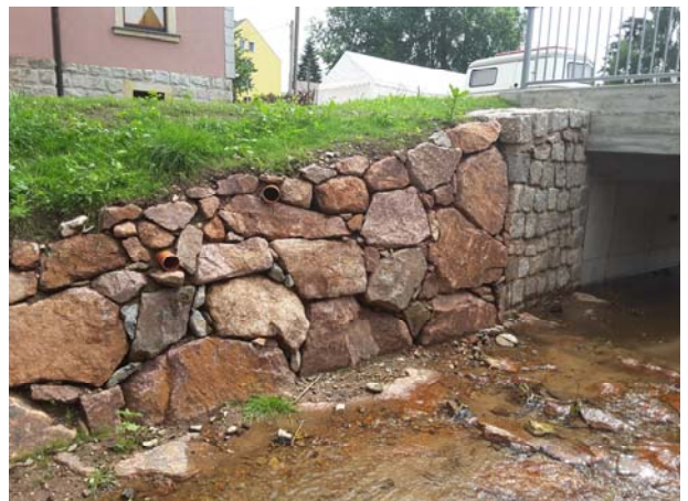
Böschung- sicherung durch Steinsatz
