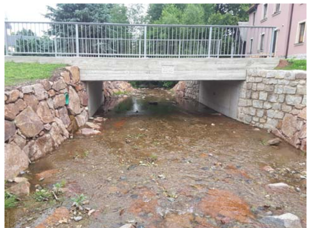
Neubau Brücke „Am Dorfbach“ Inkl. Flügelmauern
