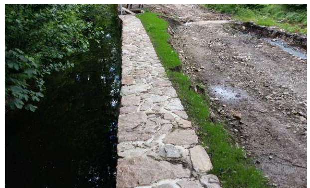
Neubau Naturstein- mauer (vermörtelt)
