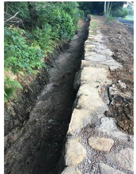
Neubau Trockenstein- mauer
