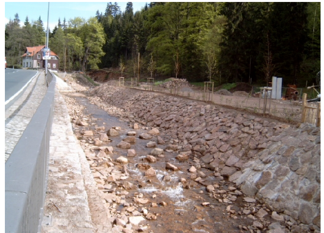
Böschung- sicherung mit Steinsatz nach DIN 19657
