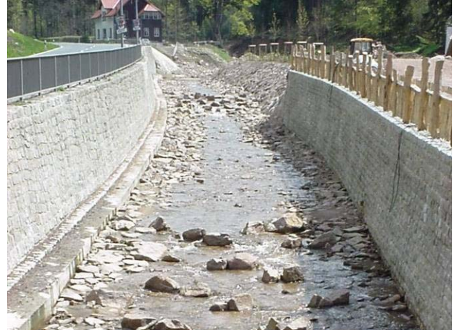
Neubau der rechten Ufermauer
