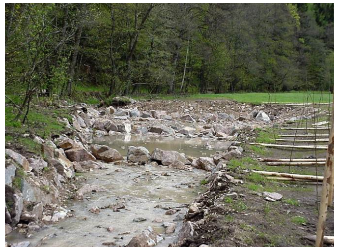
Geschiebesperre während der Bauphase 2005
