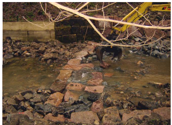
Anrampung eines Sohl Absturzes
