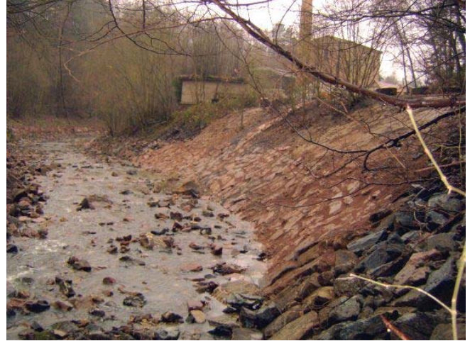
Prallhang- sicherung nach Fertigstellung
