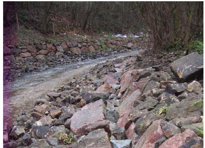
Böschungs- sicherung
