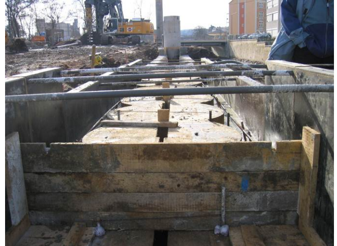
Bauzustand: Bohrpfahlwand
