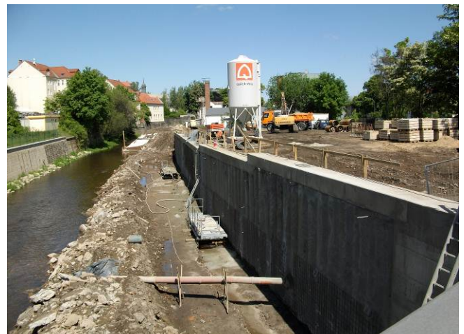
Bauzustand: Bohrpfahlwand mit Kopfbalken
