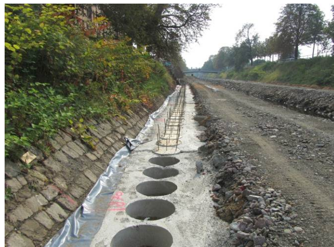
Böschungs- sicherung mit Bohrpfahlwand
