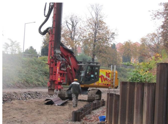
Böschungs- sicherung mit Spundwand
