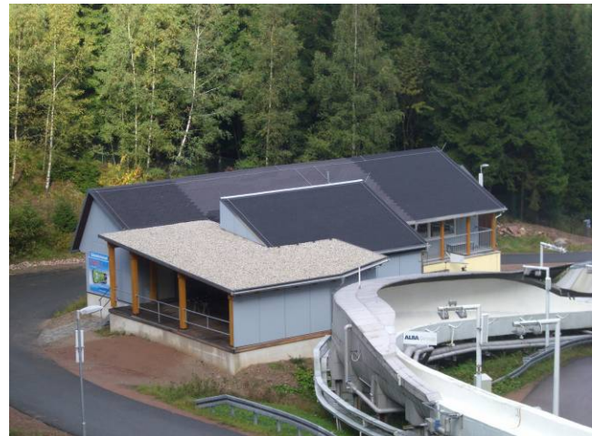
Erweiterung und Überdachung der Aufstellflächen für Sportgeräte
