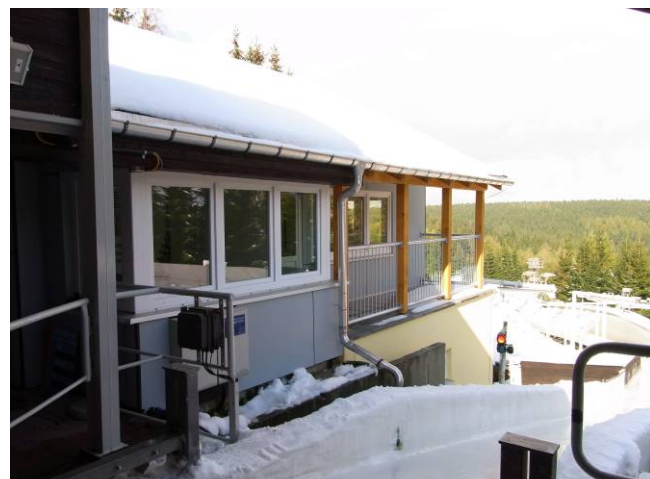
neu angebautes Gebäudeteil mit Aufenthaltsraum und Terrasse
