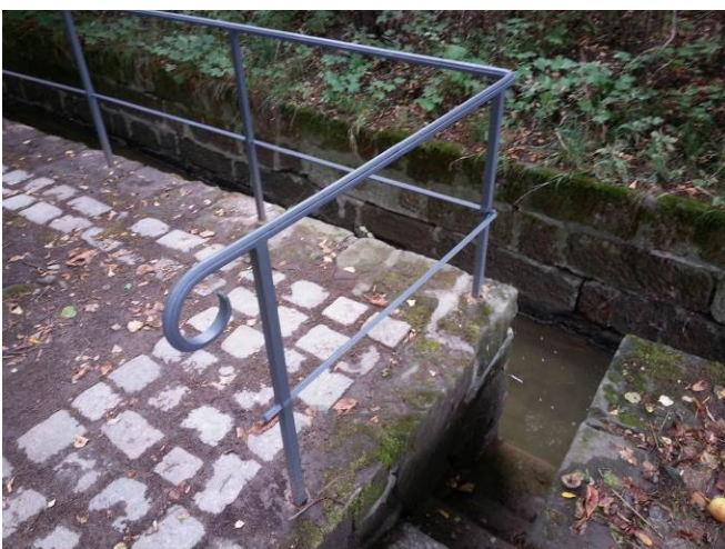
Geländer gemäß Denkmalmamt Vorgaben
