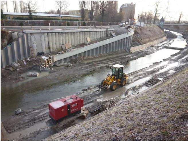
Übersicht wasserseitiger Kopfbalken ZF 4
