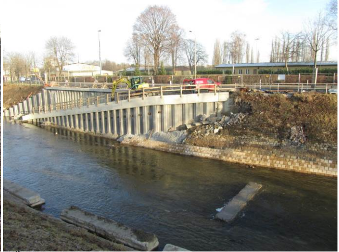
Übersicht wasserseitiger Kopfbalken ZF 4
