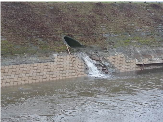
Eilaufbauwerk mit Wasserbausteinen
