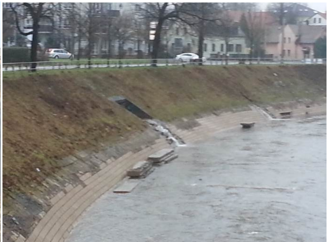
Deckwerksteine linke Böschungseite
