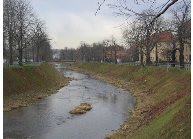
Blick stromabwärts der Vereinigten Weißeritz
