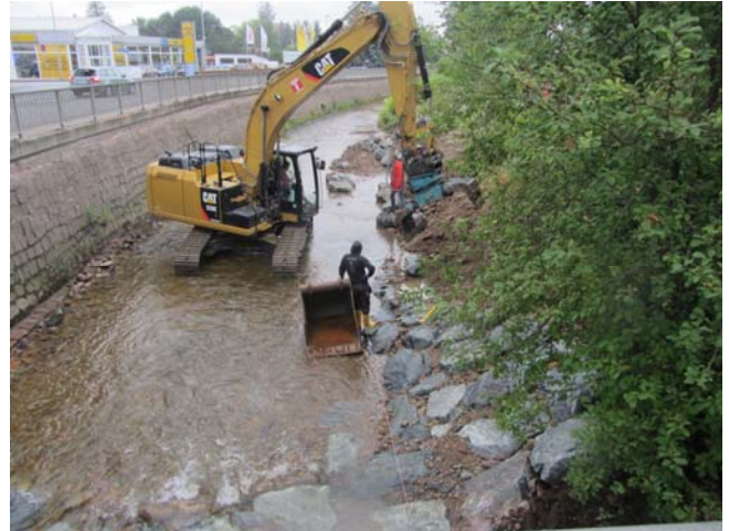
Rote Weißeritz Baubeginn
